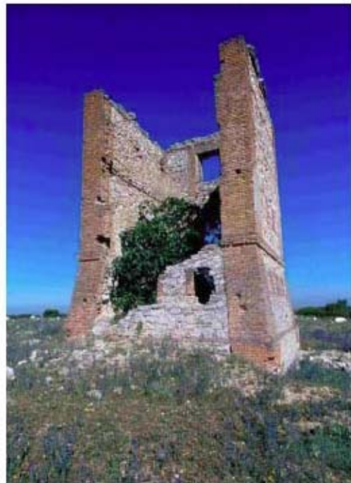
Estado de la torre antes de la intervención, alzado sur
