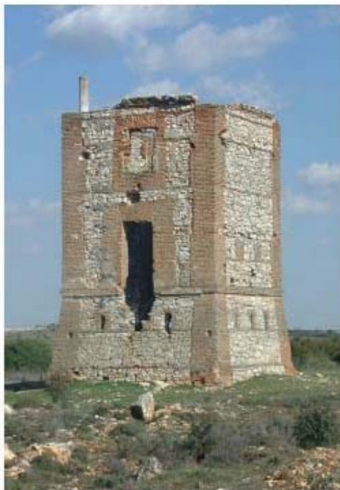
Estado de la torre antes de la intervención, alzado norte
