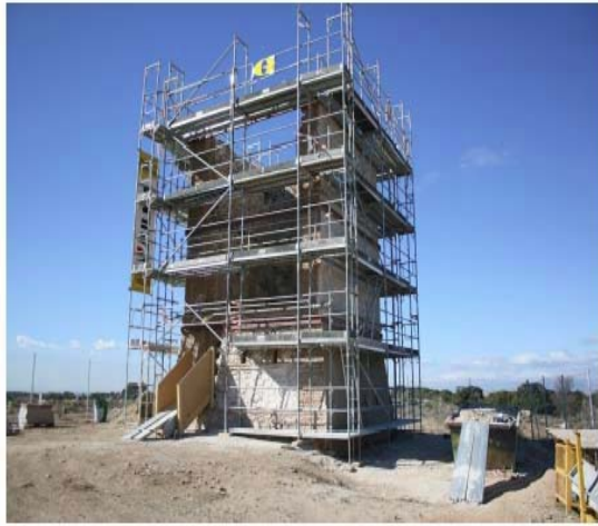
Torre durante el proceso de rehabilitación
